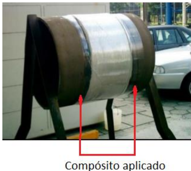
Figura 10: Aplicação de material compósito em um segmento de duto de aço [14]
