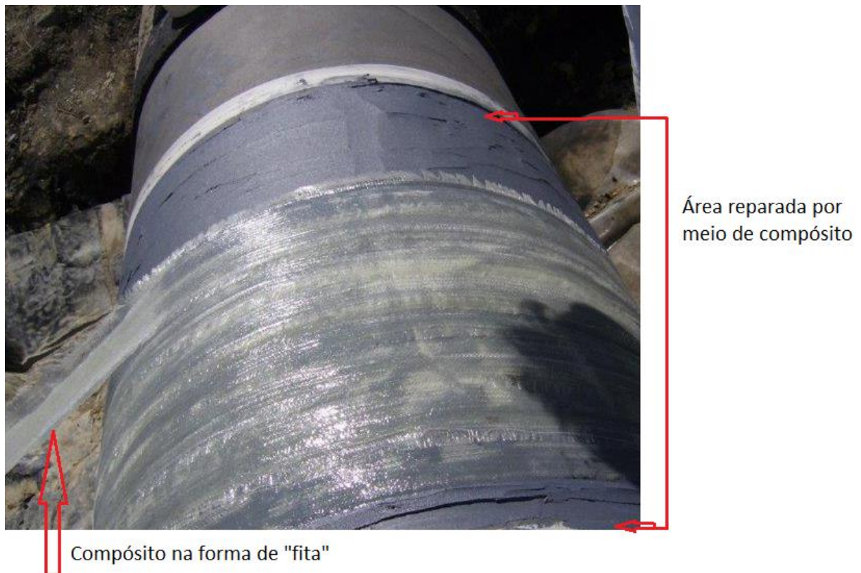
Figura 9: Reparo de tubulação utilizando compósito de fibra de carbono [13]
